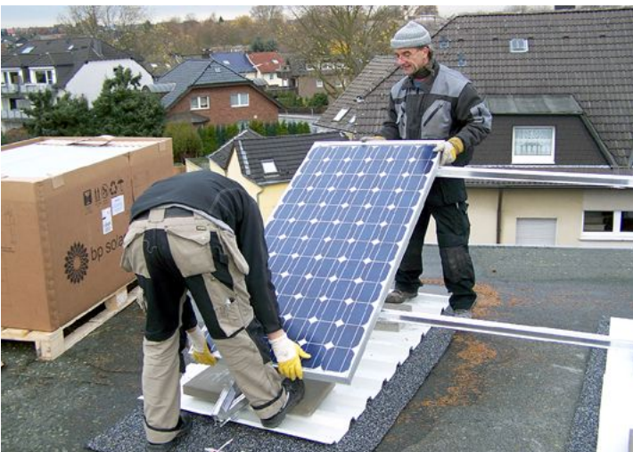
Montage Photovoltaikanlage auf einem Flachdach Dortmund, 2008
