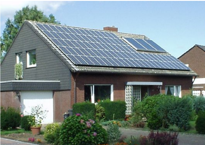
Thermische Solaranlage und Photovoltaikanlage Kollektorfläche 7,8 m 2 , Modulleistung 7,31 kWp Haltern, 2001
