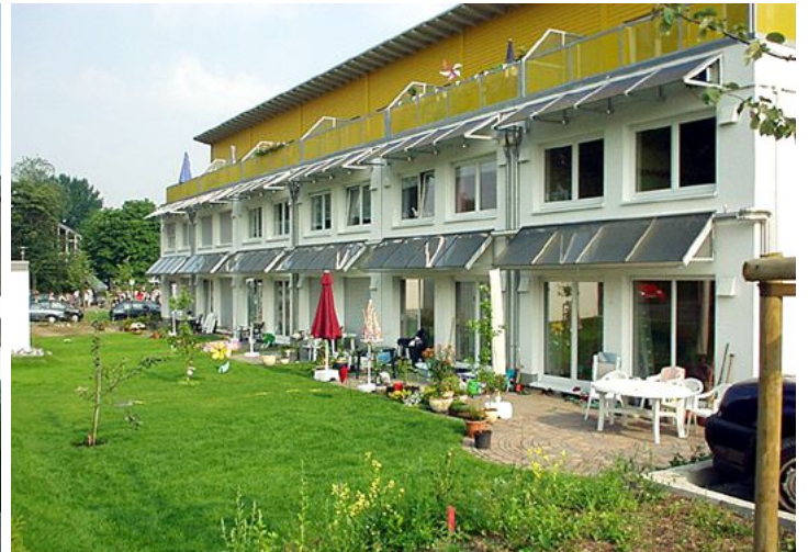
Solarsiedlung Gelsenkirchen Photovoltaik und Kollektoren an der Fassade Kollektorfläche Solarthermie insgesamt 200 m 2
