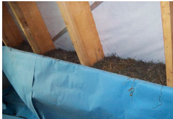
Abb. 30: loses Seegras, gestopft als Zwischensparrendämmung
