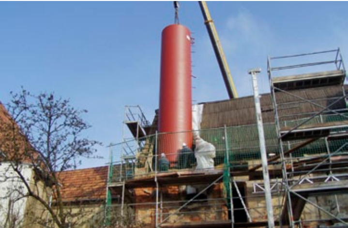
Abb. 47: Einheben des Speichers
