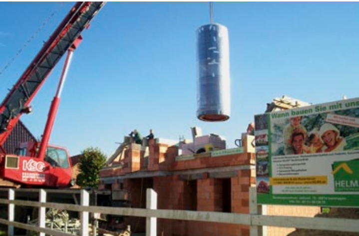
Abb. 57: Einheben des Speichers
