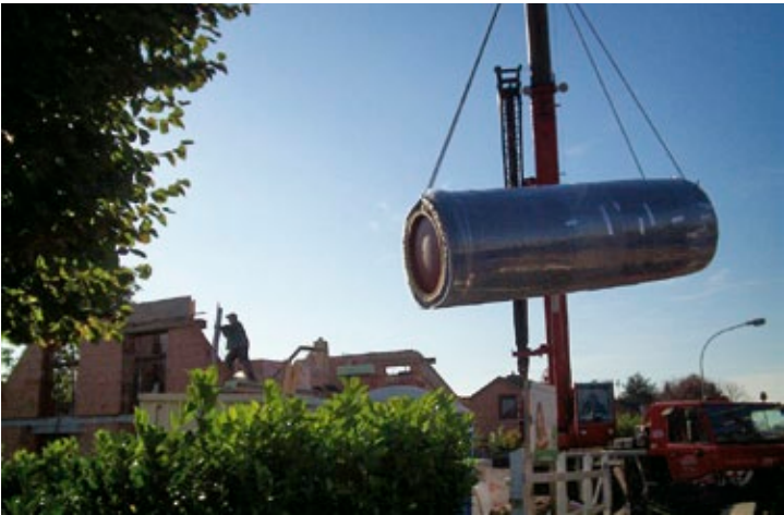
Abb. 58: Einheben des Speichers
