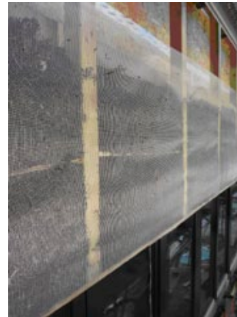
Abb. 29: loses Seegras, gestopft als Dämmung einer Kreuzlagenholz-Fassade
