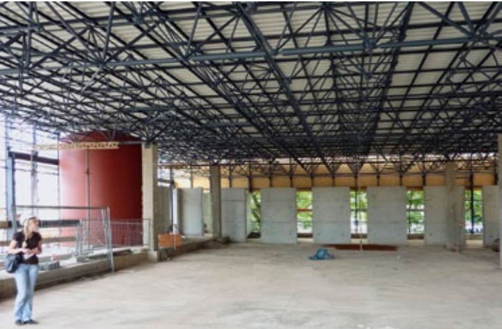
Abb. 50: Innenansicht während der Bauphase
