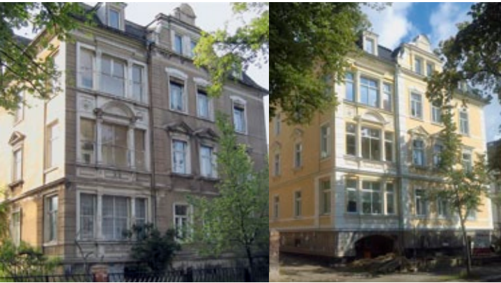
Abb. 7: Gründerzeitvilla vor und nach der energetischen Sanierung
