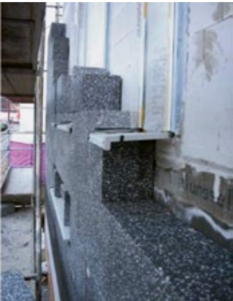
Abb. 23: Außenwand eines Passivhauses in Massivbauweise
