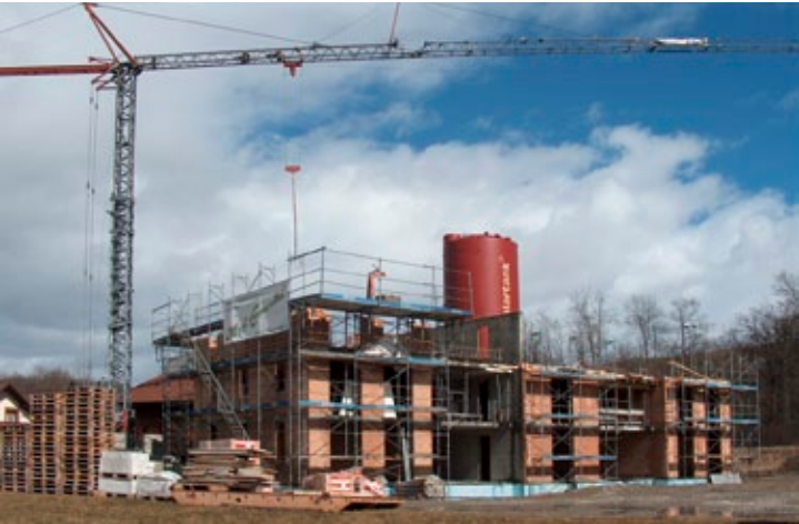
Abb. 65: Gebäude im Bau mit aufgestelltem Speicher
