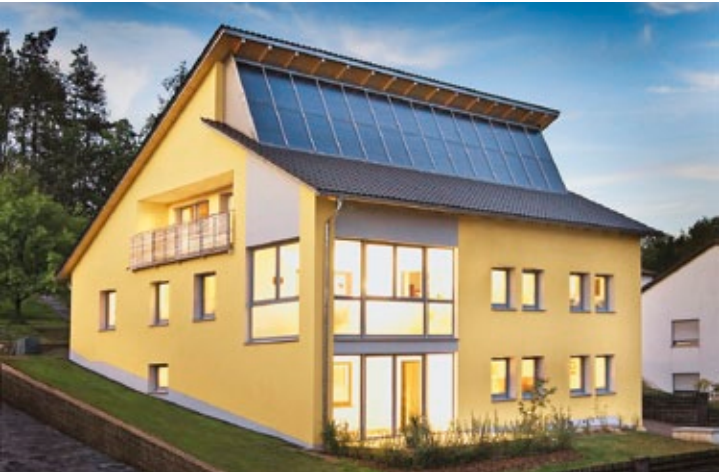
Abb. 71: Außenansicht nach Sanierung
