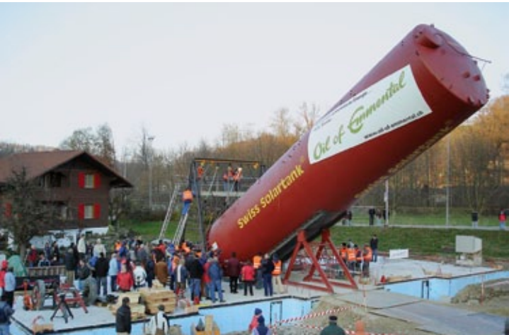
Abb. 66: Aufstellen des Speichers
