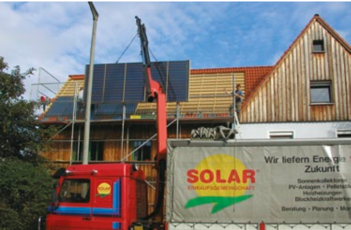
Abb. 61: Montage Kollektoren
