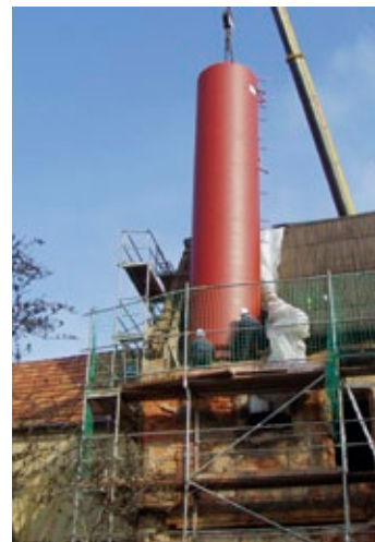
Abb. 32: Einheben des Großspeichers
