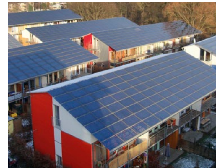
Abb. 9: Solarsiedlung »Sonnenschiff« in Freiburg
