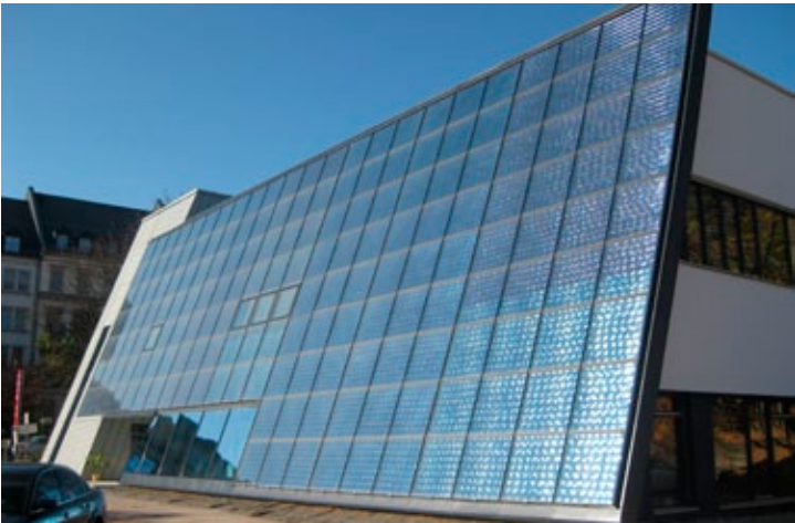
Abb. 52: fertiggestellte Fassade mit Solarkollektoren
